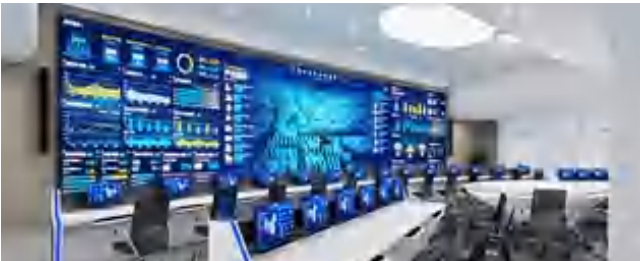
变电站视频监控系统应用
